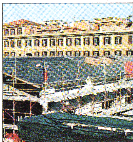
Il cantiere dell'Emporio Caritas
